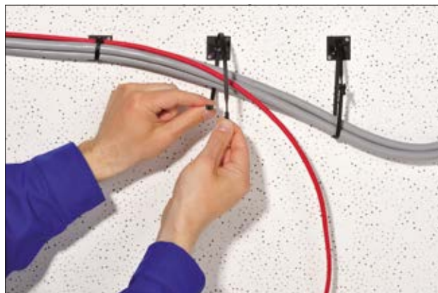
Utan extra ansträngning kan Q-tis användas för både tillfällig och permanent buntning.
